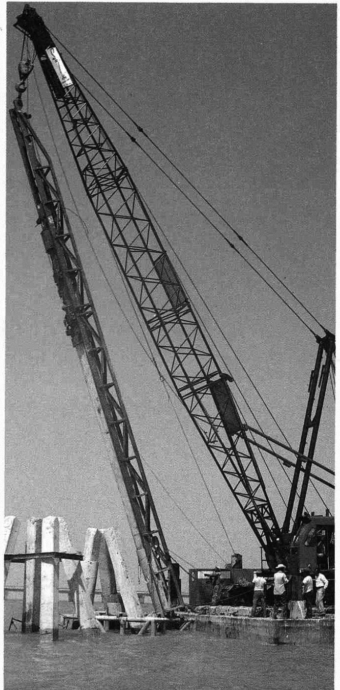
Hincado de pilotes en una torre de transmisión de energía en Campeche; izquierda, hotel Presidente Chapultepec; en la página opuesta, barco geofísico "El Metro".
