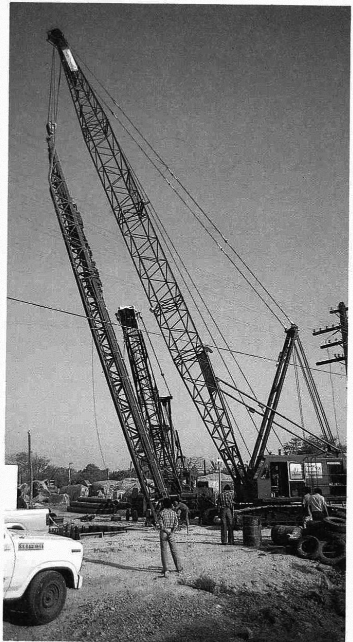
Cimentación del puente Tampico.
